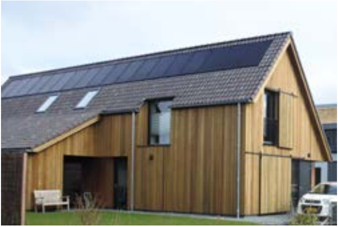
opwek van duurzame energie met een rustig geometrisch legpatroon met afstand tot de randen van het dak, en plaatsing van de warmtepomp uit het zicht van de openbare ruimte en geconcentreerd bij de bebouwing
