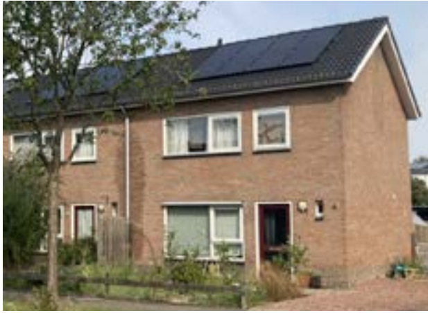
opwek van duurzame energie met een rustig geometrisch legpatroon met afstand tot de randen van het dak, en plaatsing van de warmtepomp uit het zicht van de openbare ruimte en geconcentreerd bij de bebouwing
