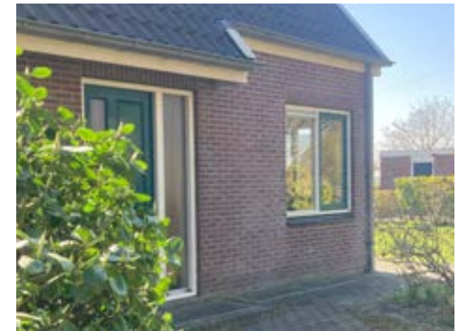
bij de voordeur schiet het dak soms door, zodat een luifel ontstaat
