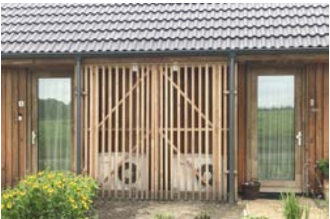
met de wijzers van de klok mee: voorbeelden van zonnepanelen in één kleur in een geometrisch legpatroon; zonnepanelen meeontworpen in de architectuur; warmtepomp bij de achterdeur; warmtepomp meeontworpen in de architectuur
