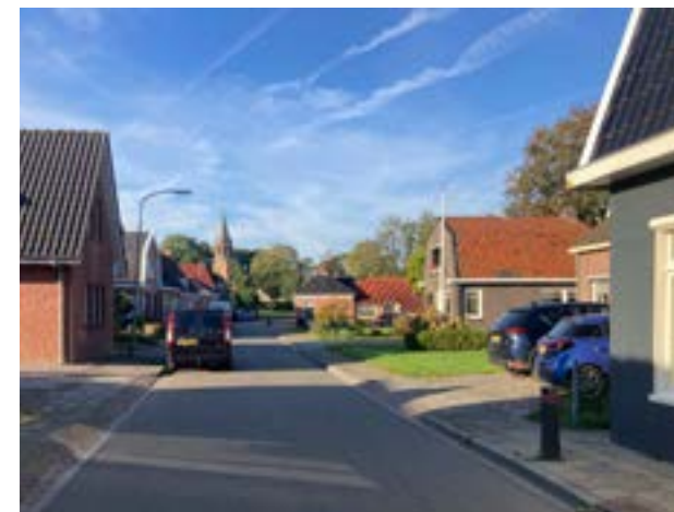
Hoofdweg, met brede rijbaan in asfalt en verhoogde trottoirs
